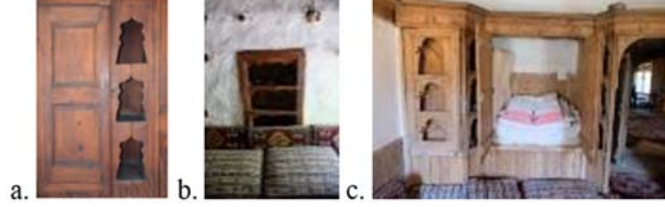
Şekil 7. a. Tembel Deliği/Takçagöz Örneği (Anonim 1), b. Antalya, Akseki Konutu Ağızıaçık Dolap Kullanımı, c. Antalya, Akseki Yüklük Üzerinde Takçagöz Örnekleri
